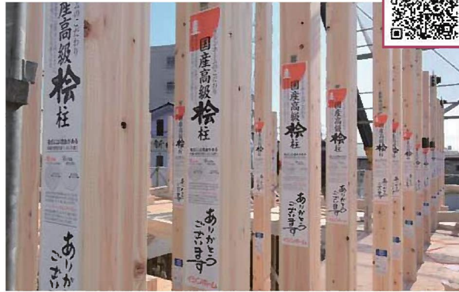
上棟日にズラッと並んだ国産桧柱
